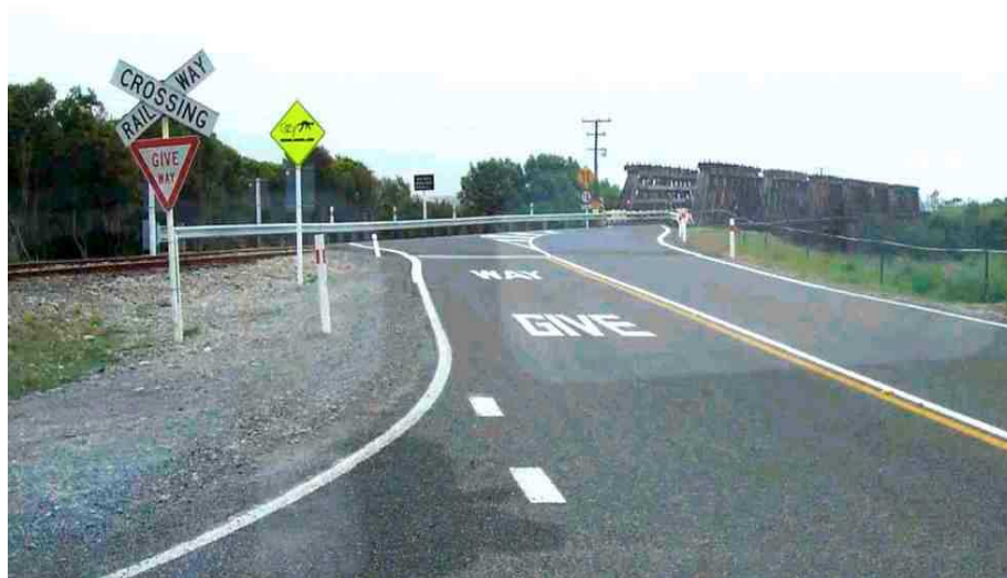
Figure 13 : Voie ferrée et route empruntant le même pont
